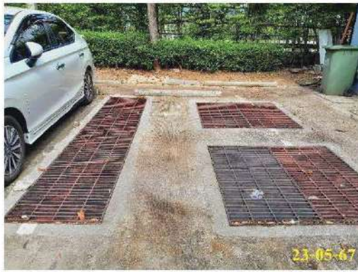
บ่อพักน้ำพร้อมตะแกรงดักขยะ พร้อมตู้ควบคุม
