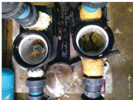
ทำความสะอาดระบบกรองสรวายน้ำ
