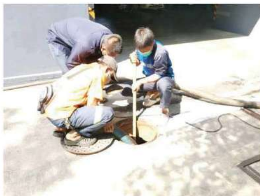
สูบลดก่อนระบบบำบัดน้ำเสีย
