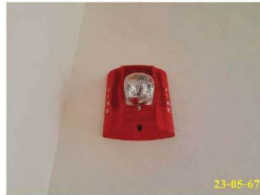
กริ่งสัญญาณเตือนภัย (Fire Alarm Speaker)
