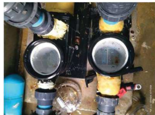
ทำความสะอาดระบบกรองสรวายน้ำ
